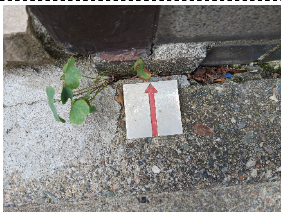
A2 近景 既設金属プレート
