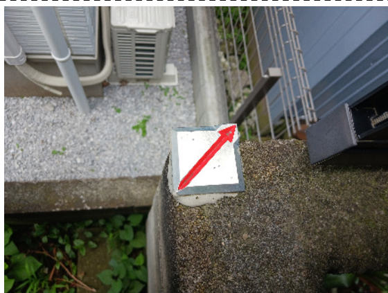
R4X6 近景 既設金属プレート
