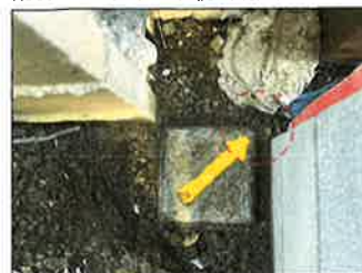
K350 コンクリート杭 (既設)
