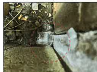
K349 コンクリート杭 (既設)
