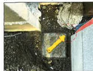
K350 コンクリート杭 (既設)
