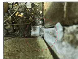
K349 コンクリート杭 (既設)
